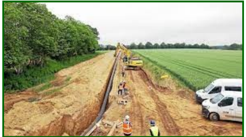
Les Canalisations dans la Tranchée
