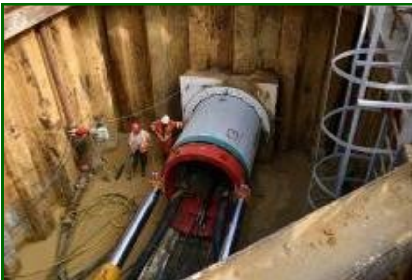
Préparation de la Traversée de l'A6 en Côte-d'Or
