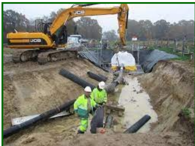
Le Fond de la Tranchée
