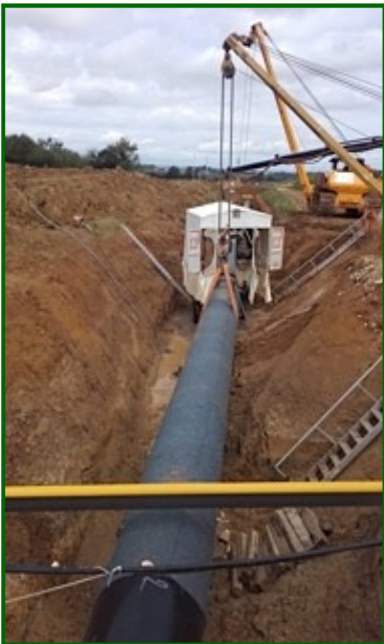
Soutien de la Canalisation Pendant la Soudure
