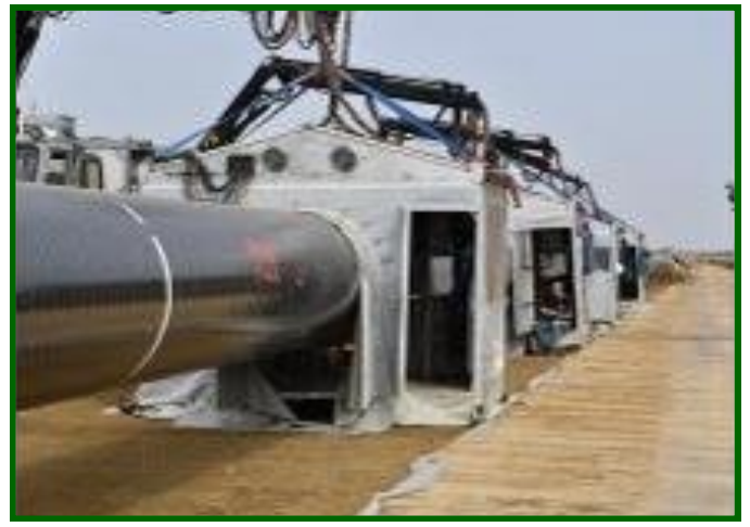
Les Soudures sont réalisées sous cette Protection
