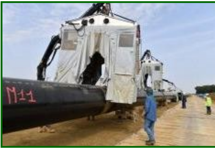
Les Soudures sont réalisées sous cette Protection
