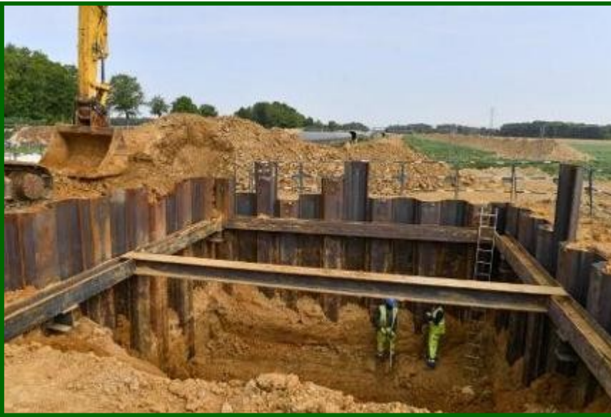
Traversée de la D996 par un Forage Classique
