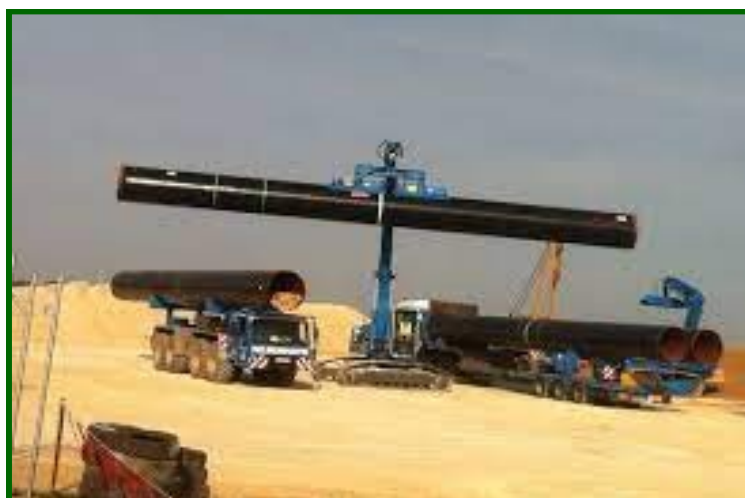
Le Déchargement des Canalisations
