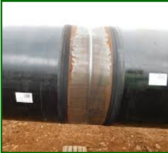
Détail d'une Soudure
