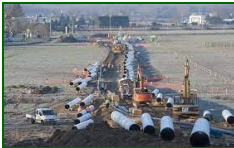
L'arrivée des Canalisations sur le Chantier
