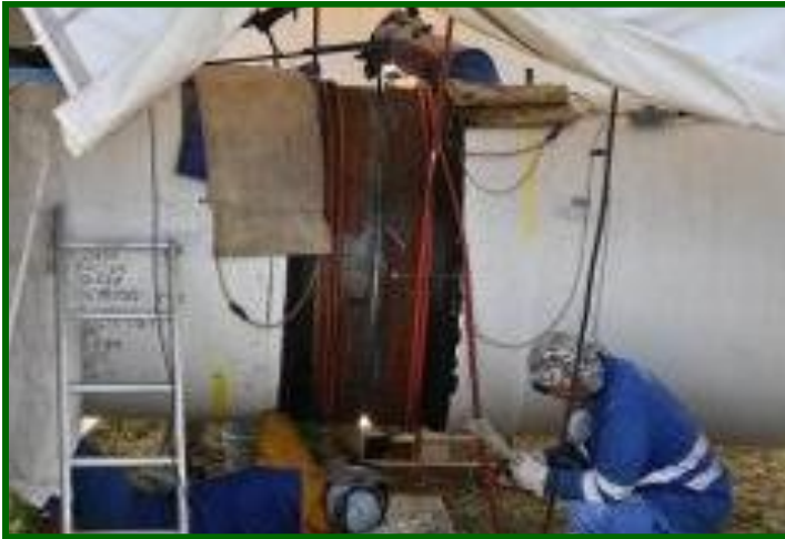
Soudures sous la Protection
